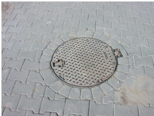
Fot.1-2 Detal obróbek wokół słupa i studzienki kanalizacyjnej
